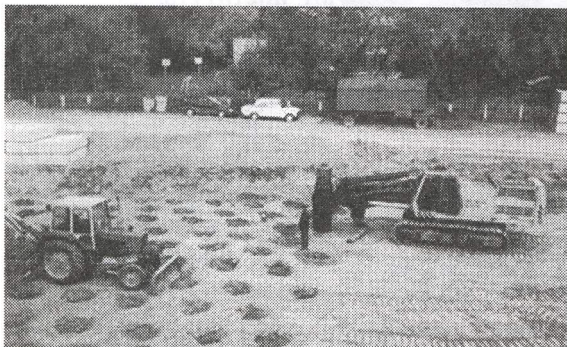
Агрегат глубокого трамбования грунта
